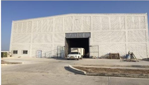
Foto No. 1 Vista general de la Bodega.
