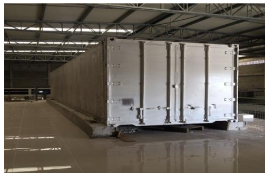
Foto No. 04 cuarto frío almacenamiento de pieles
